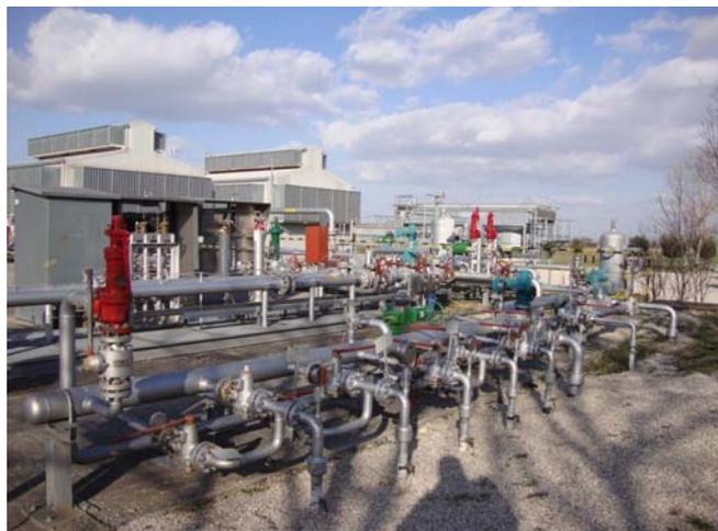
In figura l'arrivo delle flow line che collegano la centrale ai pozzi
